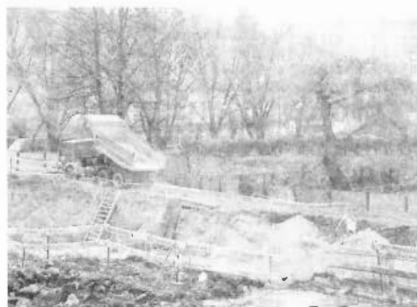
Zakończono już wykopy szeroko-przestrzenne...
