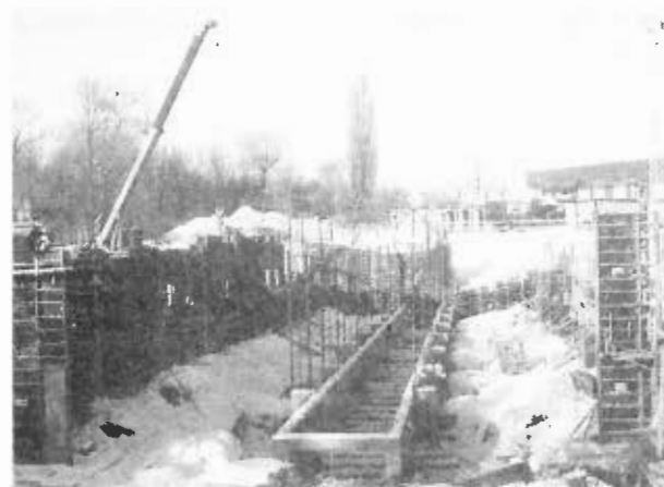
...oraz wykonano ok. trzydzieści procent robót fundamentowych obiektu
