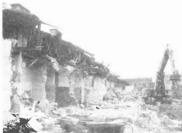
20 listopada 2003 r. na plac budowy wkroczyły ekipy budowlanych
