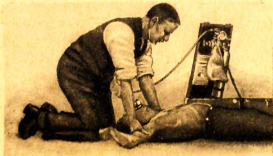
Ryc. 27. Aparat tlenowy ratowniczy Draegera Model „C” w akcji. Sztuczne oddychanie metodą Silvestra — akt wdechu, z równoczesnym podawaniem tlenu (według Draegera Liste: W. 1929).
